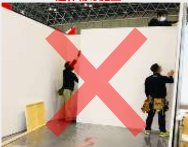
造作物の施工
